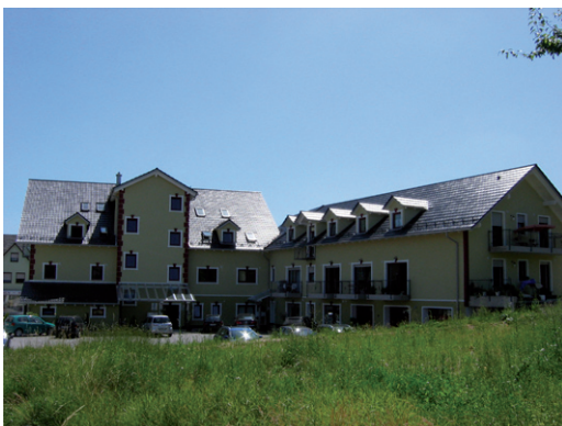
Die besonders energieeinsparenden Ventilatoren VMF/S 1400 EC wurden hängend unter dem Dach angebracht.
