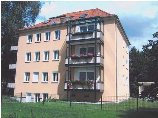
Sanierungsbeispiel: Aereco-Lüftungsanlage im Mehrfamilienhaus
