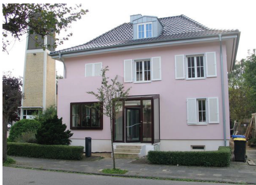
Das Einfamilienhaus erreicht die höchste Anforderung „Level B“ des Dena-Modellvorhaben „Niedrigenergiehaus im Bestand“ und den Status eines KfW-40-Hauses.
