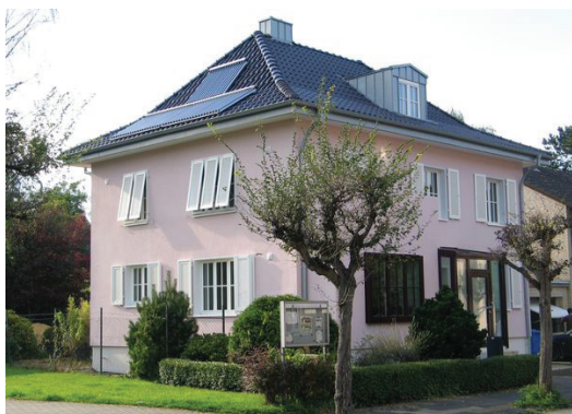
Die sanierte 50er Jahre Villa erfüllt den Standard eines Niedrigenergiehauses.
