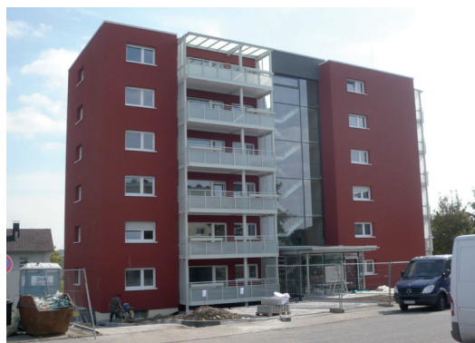
Die Modernisierungsmaßnahmen wurden im September 2009 abgeschlossen (Sanierungsbeginn: Mai 2009).
