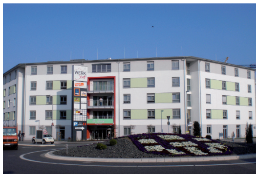
Das Mehrgenerationszentrum St.-Georg befindet sich in der Innenstadt von Limburg.
