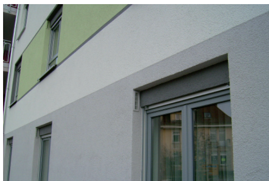
Von Aussen kaum sichtbar: Die Ansaugung des Zuluftset KWHRVA 02 WDVS K erfolgt verdeckt über die Fensterlaibung im WDVS.
