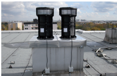
Auf dem Schachtkopf sitzen die DC-Ventilatoren DVND 315
