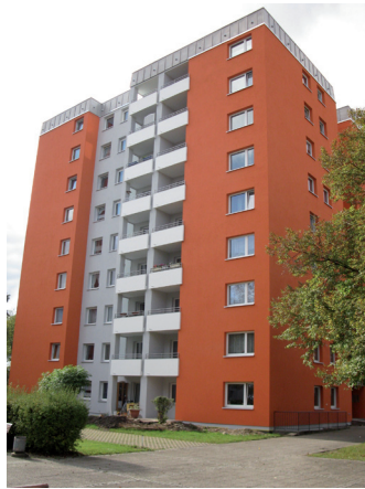
In den 132 Wohneinheiten dieser Gebäuden wurde die vorhandene Freie Lüftung energetisch ertüchtigt.
