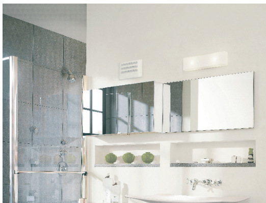
In den Bädern wurden die Abluftgittern mithilfe einer Adapterplatte von feuchtegeführte Abluftelemente ersetzt.
