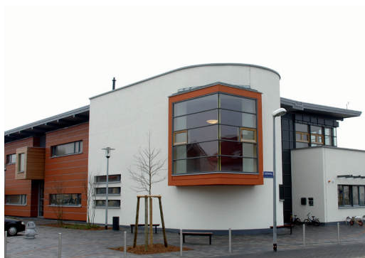
Für eine bessere Integration in die Fassade wurden die Wetterschutzhauben des Zuluftsets KWHRVA 02 in den entsprechenden Farben lackiert.
