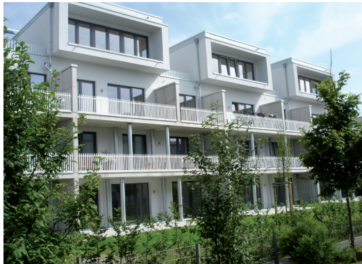
Die 16 Wohneinheiten wurden im KfW-Effizienzhaus-Standard 55 neugebaut.
