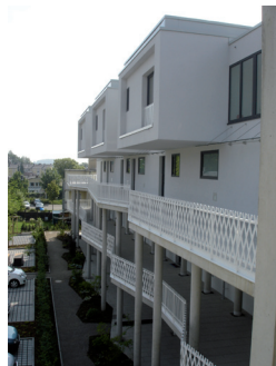
Die Nachströmung der frischen Luft erfolgt über die am Fenster platzierten Zuluftelement ZFHVA 5-35.
