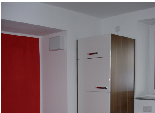
In den Küchen wurden die feuchtegeführte Ablufterelemente AH 80 mit Fettfilter AFR 01 eingesetzt.
