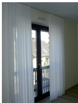
Die Bewohnerzimmer sind mit dem feuchtegeführten Zuluftelement für Rolladenkasten ZWRH 30 ausgestattet.
