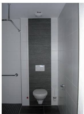
Die nutzerunabhängigen feuchtegeführten Abluftelementen AHSONZ 80 sorgen für das Absaugen der verbrauchten Luft. Eine Intensivlüftung erfolgt über Präsenzerfassung.
