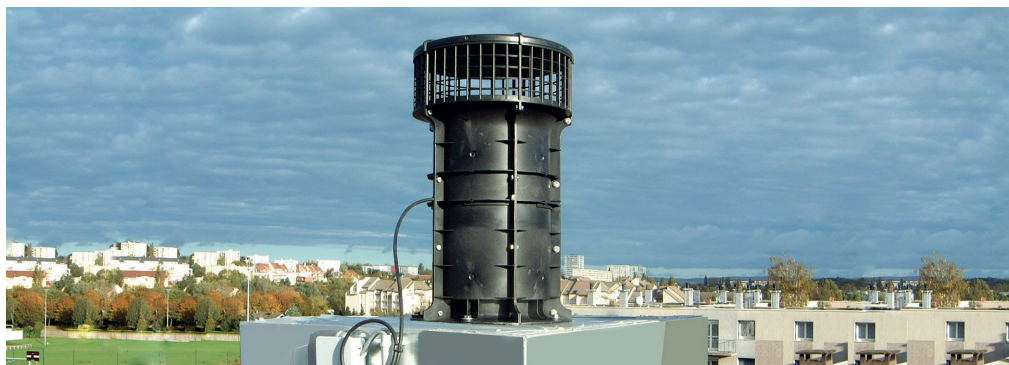
Das Abluftelement wird am Lüftungsschacht angebracht
