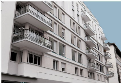
Mehrfamilienhäuser in Paris
