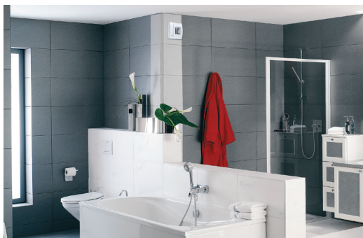
In den Bädern und Küchen wurden bedarfsgeführte Abluftelemente eingesetzt. Diese sorgen für eine dem Bedarf angepasste Entlüftung und sind an das Brandschutzkanalsystem VENTISAFE angeschlossen (Beispielbild).
