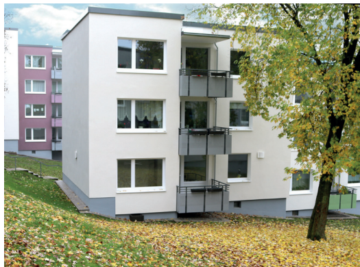
Im Mehrfamilienhaus in Remscheid ist die Wohnung im Erdgeschoss mit dem bedarfsgeführten, dezentralen Lüftungssystem mit Wärmerückgewinnung LAD easy ausgestattet.
