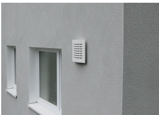
Auf der Außenfasade der Wohneinheit befindet sich die Wetterschutzhaube mit optimierter Strömungsführung.
