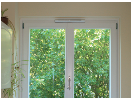
In den Schlaf- und Wohnräumen wurden die Außenluftdurchlässe ZFH 5-35 am Blendrahmen eingesetzt.
