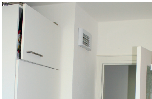
Abluftseitig wurden die Elemente der Serie 72 in den Küchen und Badezimmern verwendet.
