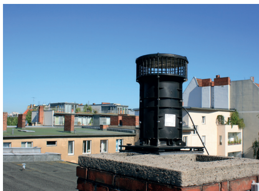
Auf dem Flachdach wurden die Hybridventilatoren (DVND) von Aereco an die vorhandenen Schächte angeschlossen
