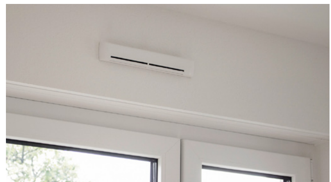
2 Außenluftdurchlass Aereco, Typ ZUROH 100, am Aufsatzrollladenkasten
