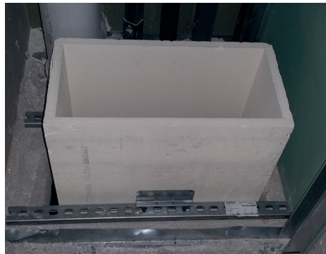
Ventisafe-Kanalsysteme sollten während der Einbauphase gegen Feuchteintritt geschützt werden.
